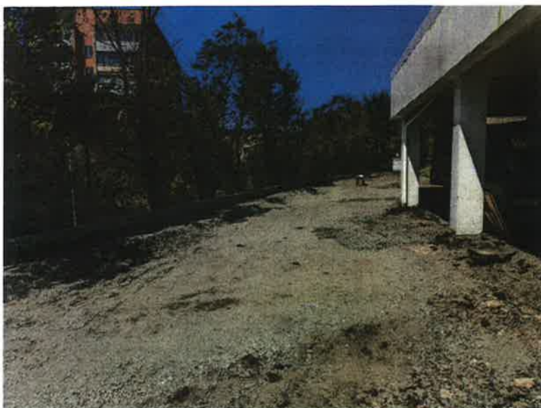
Фото 1.8 Территория, прилегающая к зданию
