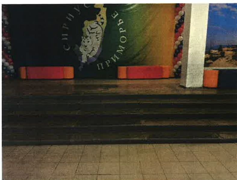
Фото 3.4 Лестница в холле 1-го этажа
