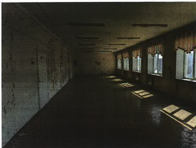
Фото 3.29 Холл 3-го этажа
