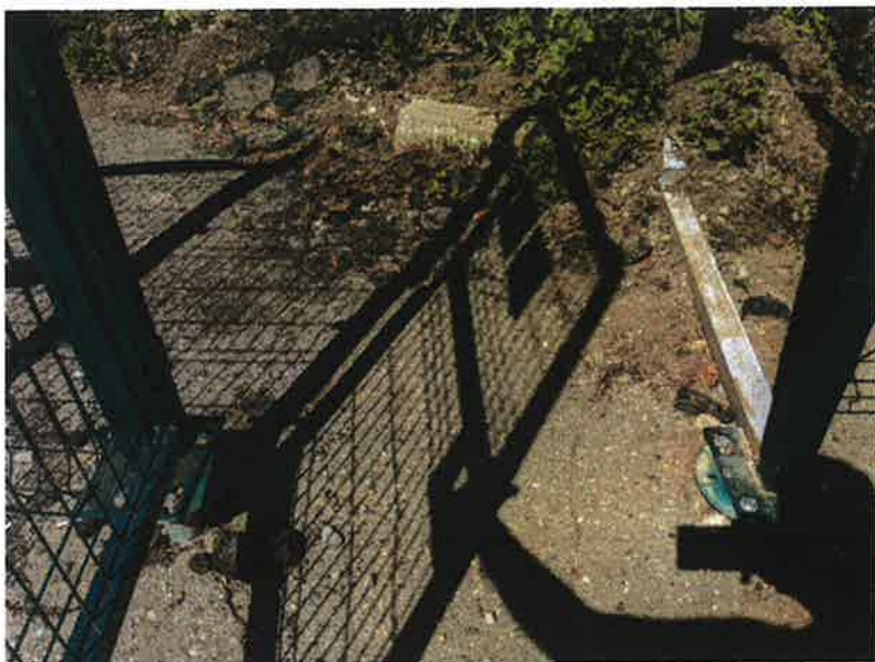
Фото 1.4 Калитка основного входа на территорию
