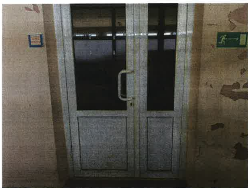
Фото 3.30 Дверь в коридор 3-го этажа
