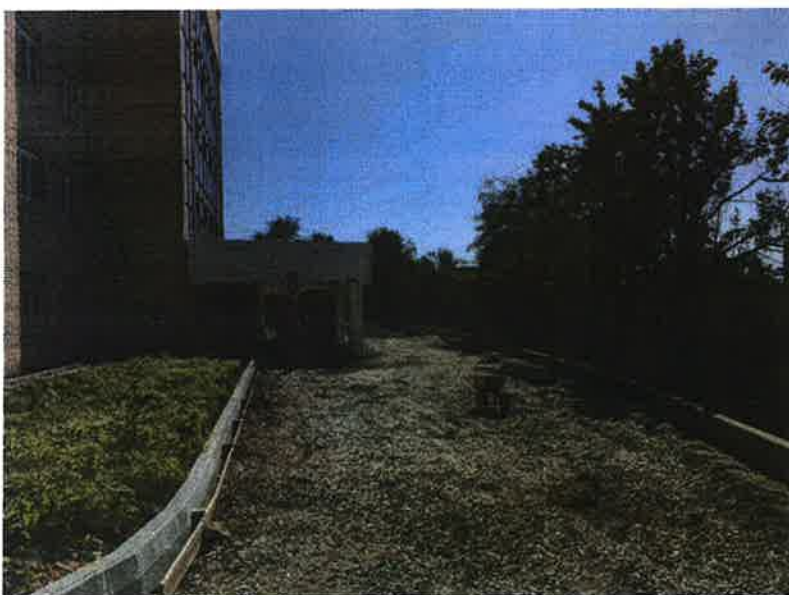
Фото 1.9 Территория, прилегающая к зданию
