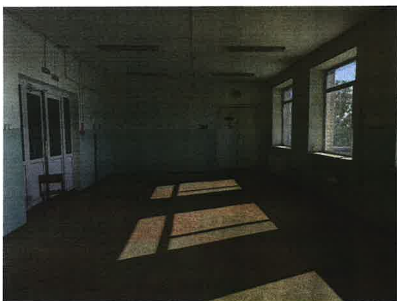
Фото 3.48 Холл 5-го этажа
