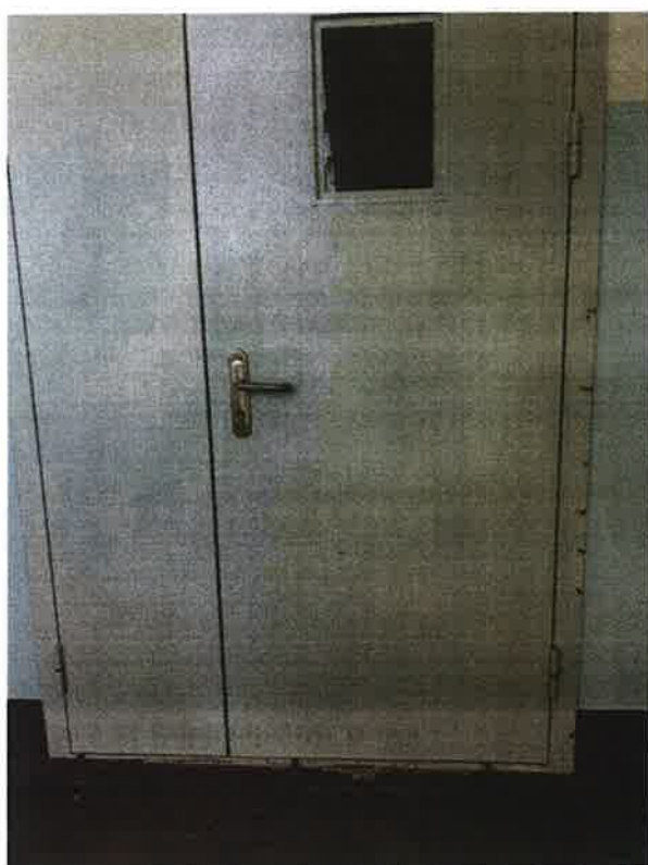
Фото 3.33 Дверь от лестницы к холлу 4-го этажа
