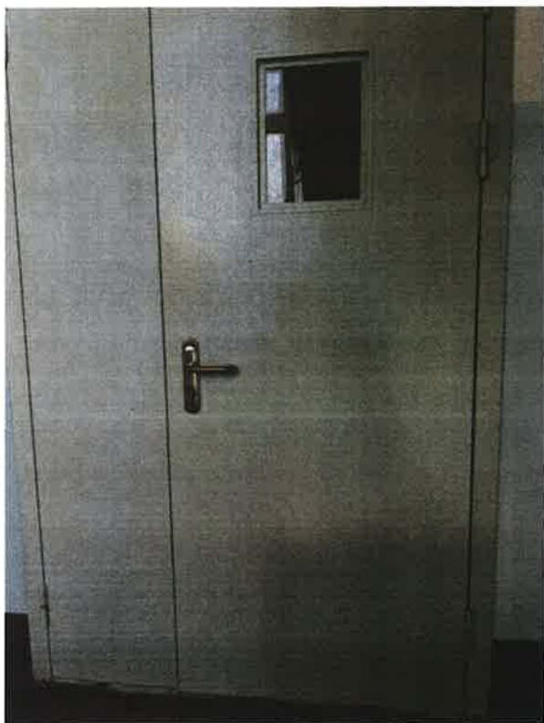
Фото 3.24 Дверь от лестницы к холлу 3-го этажа
