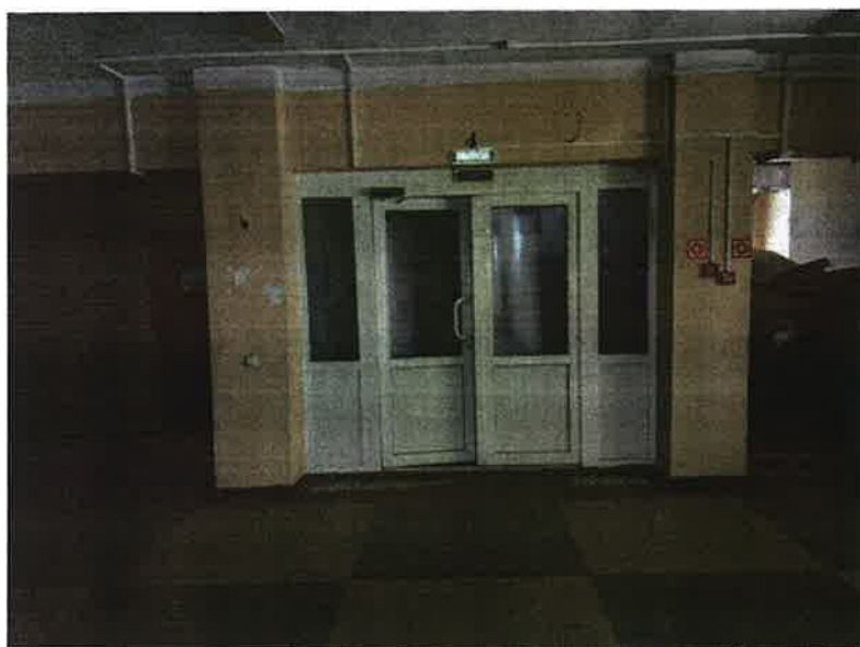
Фото 3.39 Дверь к межэтажной лестнице
