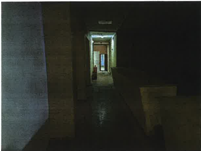
Фото 3.12 Коридор на 1-м этаже
