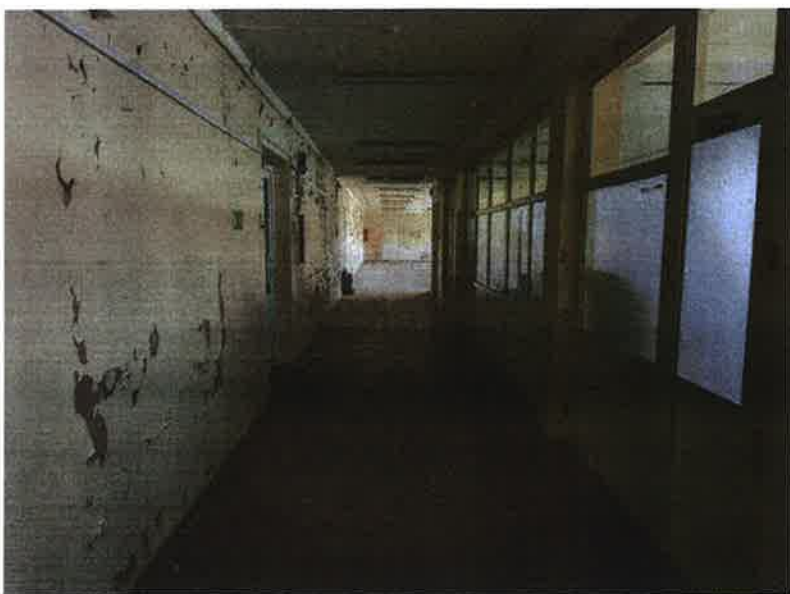
Фото 3.28 Холл 3-го этажа
