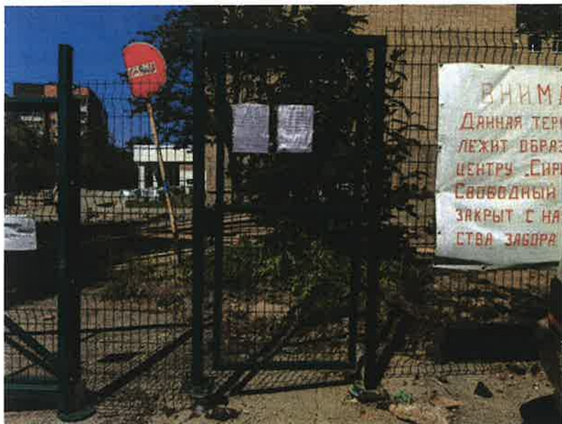
Фото 1.2 Калитка основного входа на территорию
