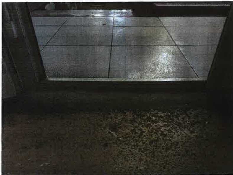
Фото 3.17 Порог двери, ведущей к межэтажной лестнице на 1-м этаже
