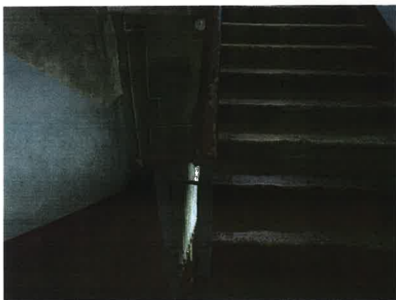
Фото 3.41 Поручни межэтажной лестницы
