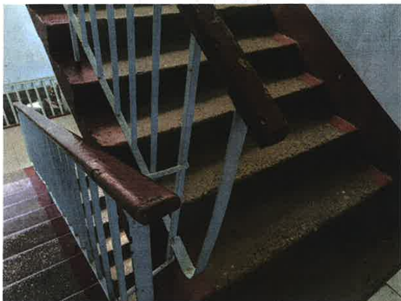
Фото 3.22 Поручень межэтажной лестницы
