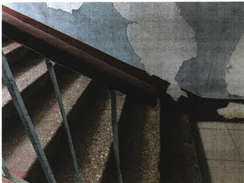
Фото 3.18 Поручень межэтажной лестницы
