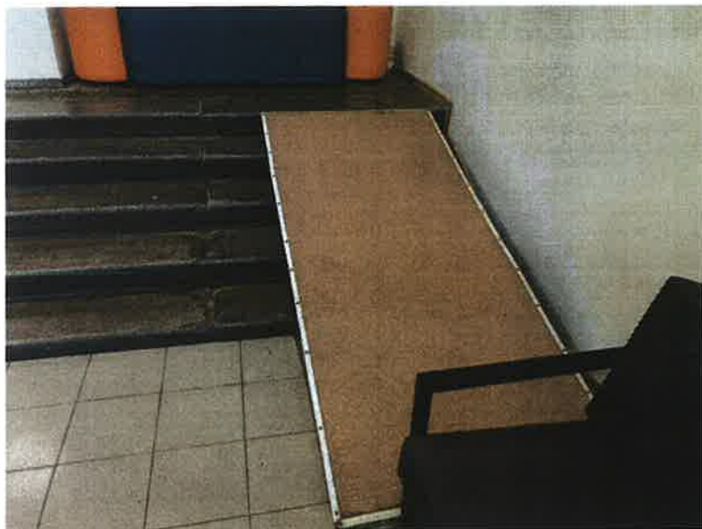
Фото 3.6 Пандус в холле 1-го этажа
