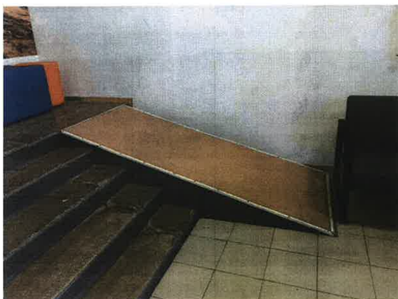
Фото 3.5 Пандус в холле 1-го этажа
