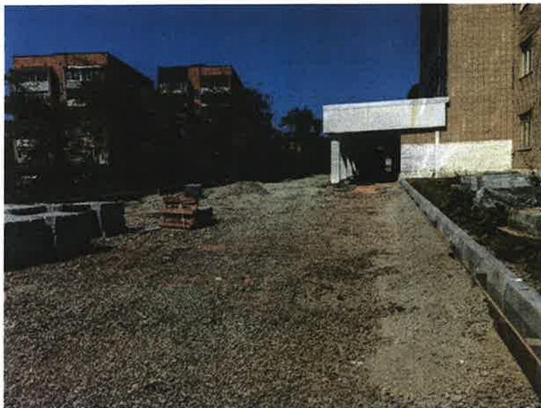
Фото 1.7 Территория, прилегающая к зданию
