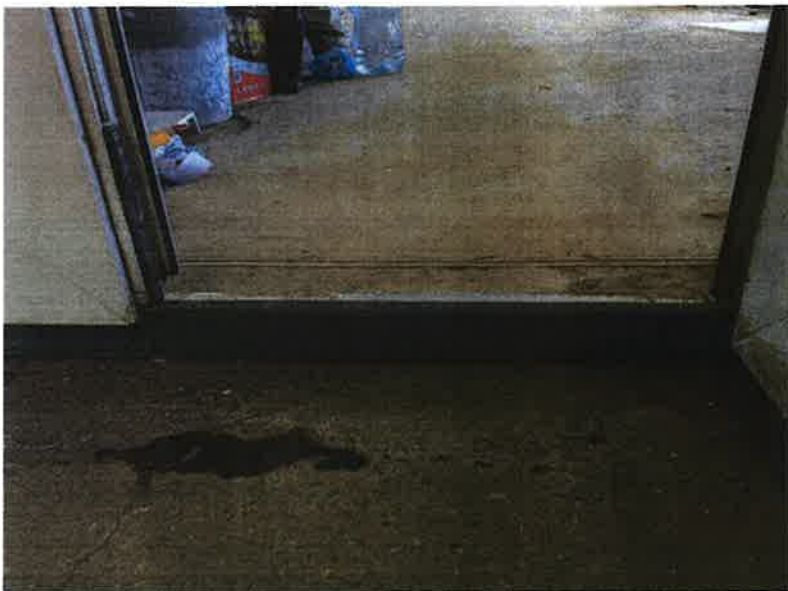
Фото 3.14 Порог двери в боковой холл 1-го этажа
