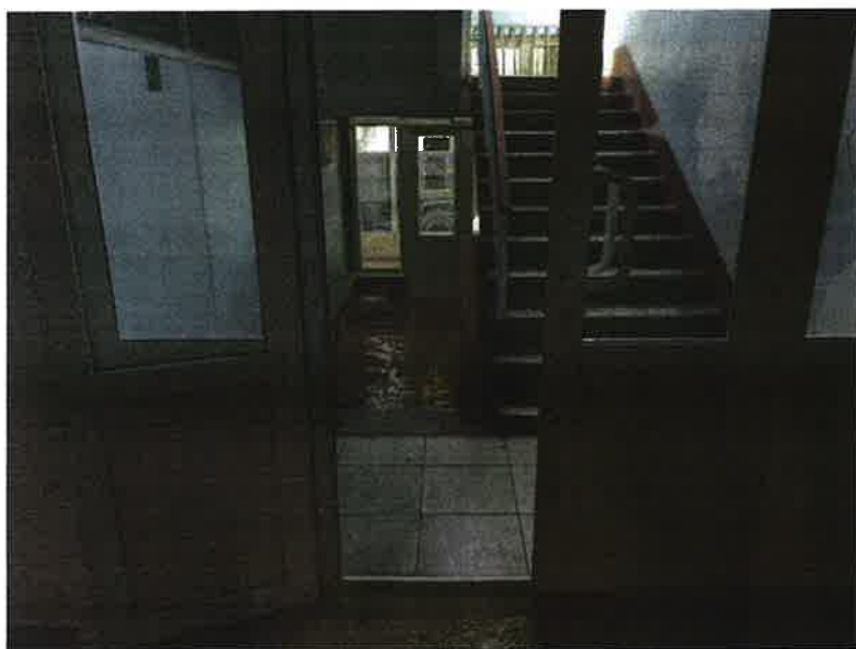
Фото 3.16 Дверь, ведущая к межэтажной лестнице на 1-м этаже
