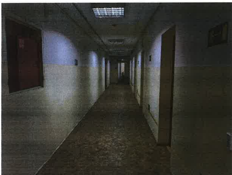
Фото 3.20 Коридор 3-го этажа
