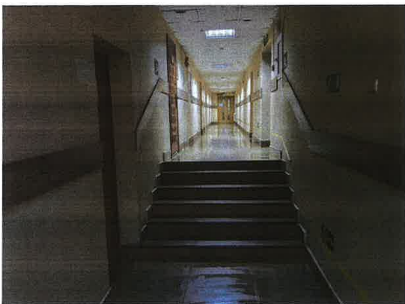
Фото 3.7 Лестница в коридоре на 1-м этаже
