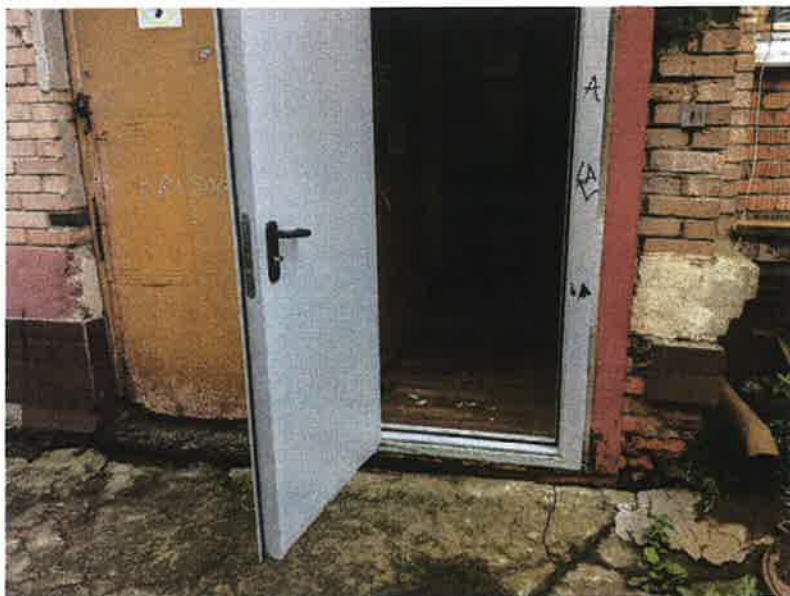
Фото 3.27 Дверь эвакуационного выхода
