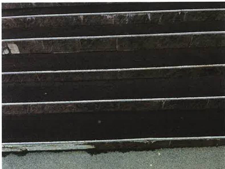
Фото 2.3 Лестница перед входом в здание
