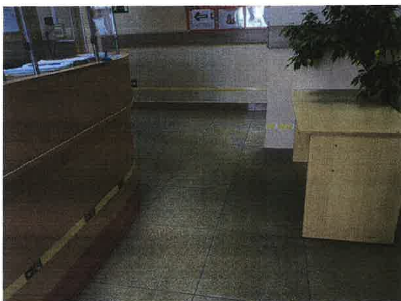
Фото 3.4 Холл 1-го этажа
