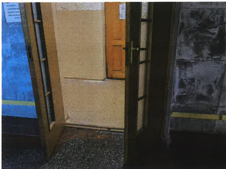
Фото 3.16 Дверь в коридор 2-го этажа
