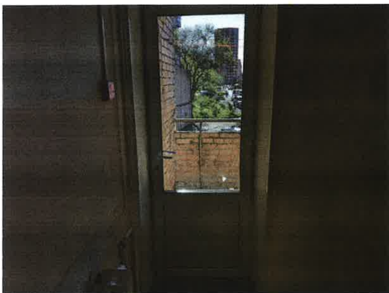
Фото 3.28 Дверь эвакуационного выхода
