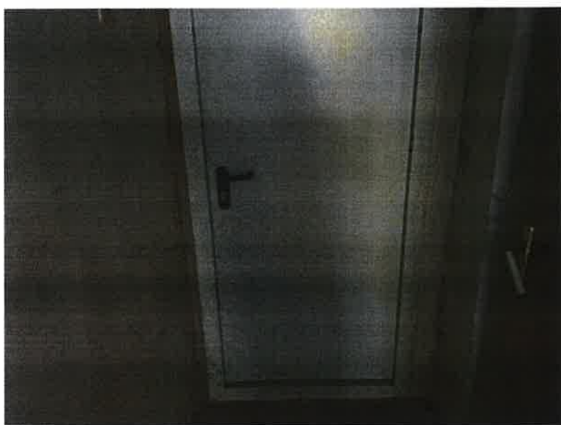
Фото 3.25 Дверь эвакуационного выхода
