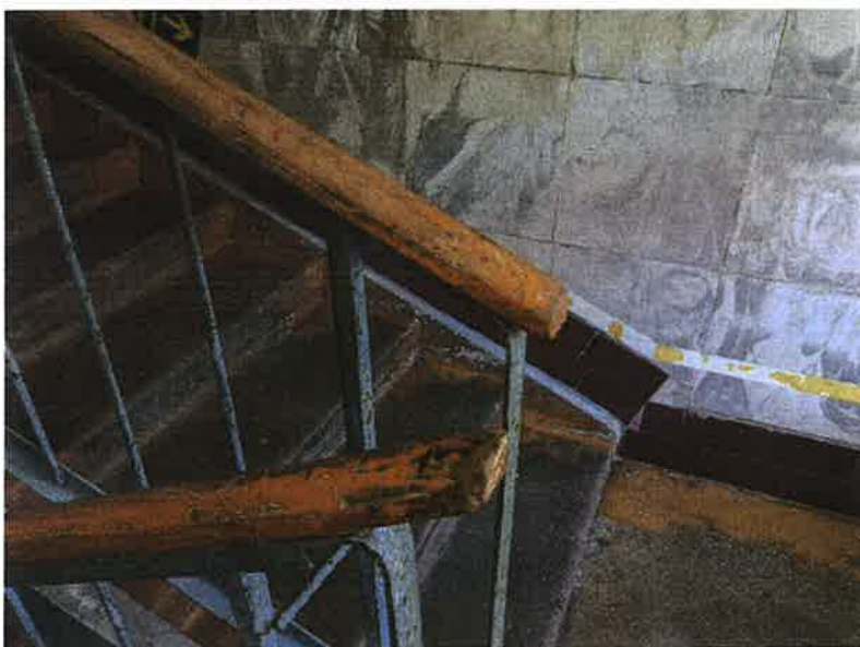
Фото 3.13 Поручни межэтажной лестницы
