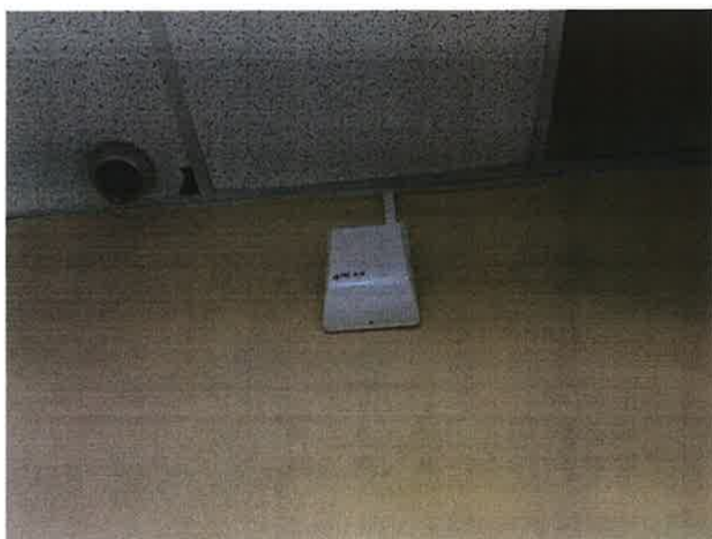
Фото 6.14 Звуковой оповещатель
