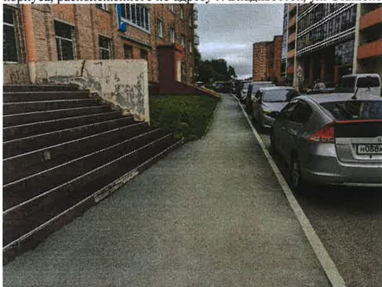
Фото 1.1 Территория перед входом в здание
