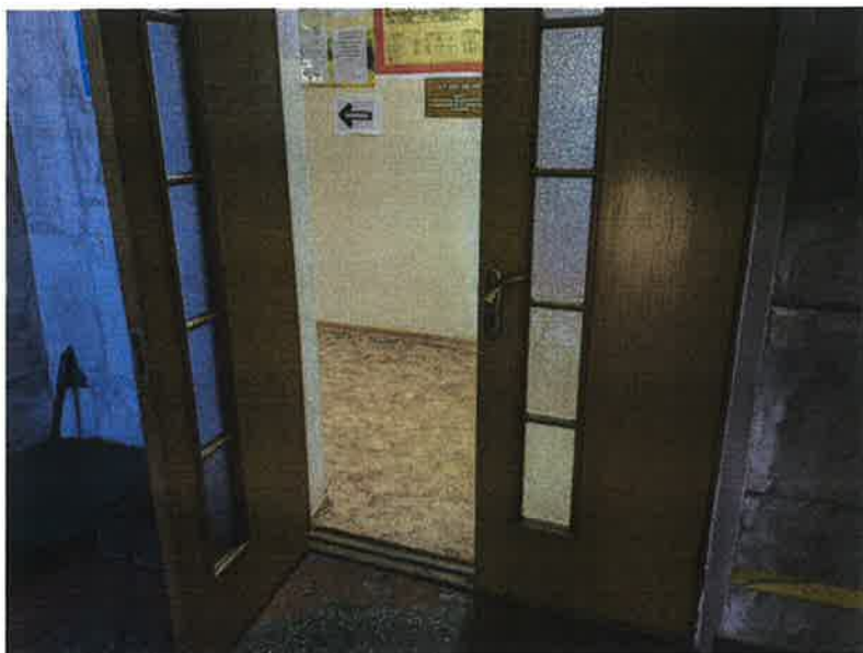
Фото 3.19 Дверь в коридор 3-го этажа
