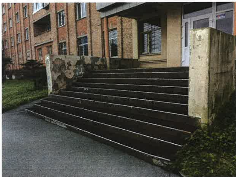
Фото 2.1 Лестница перед входом в здание
