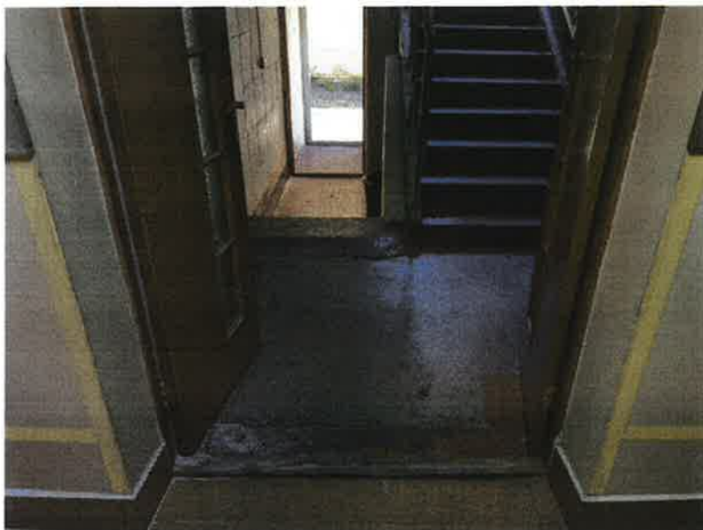
Фото 3.11 Дверь к межэтажной лестнице
