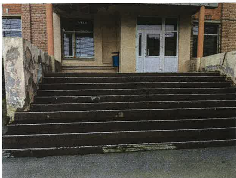
Фото 2.2 Лестница перед входом в здание
