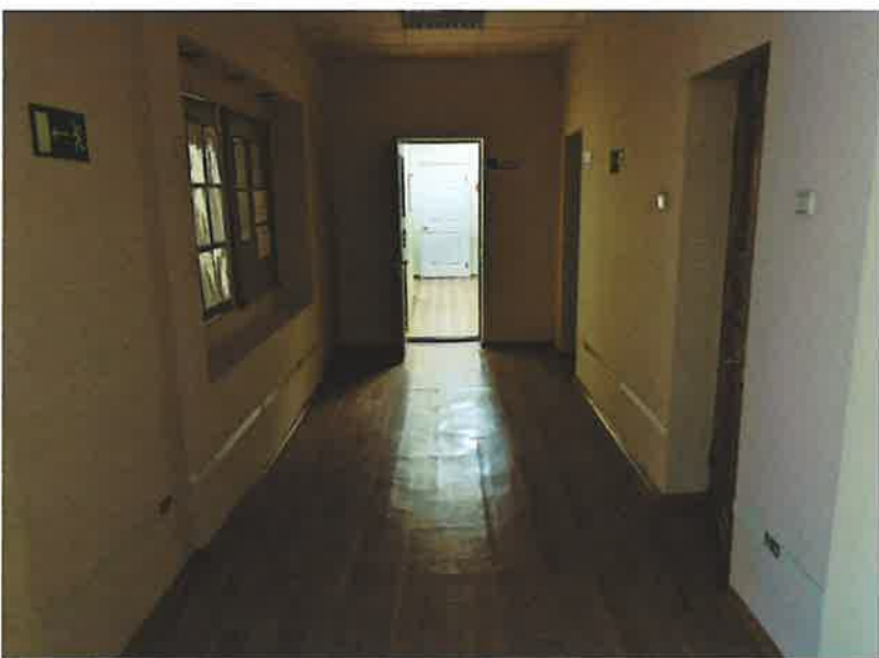
Фото 3.17 Коридор на 2-м этаже
