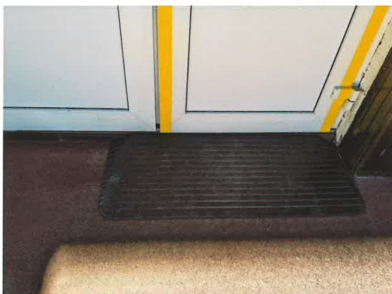
Фото 2.4 Пороговый пандус перед входной дверью
