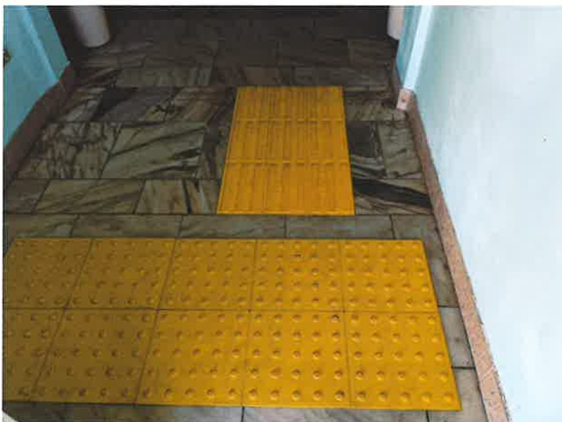
Фото 2.7 Предупреждающие тактильные указатели перед входной дверью
