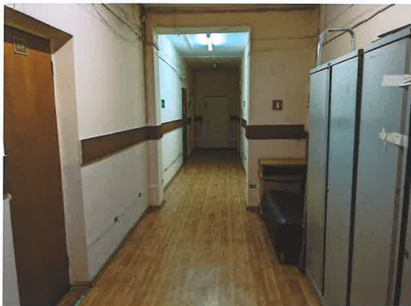
Фото 3.7 Коридор на 1-м этаже
