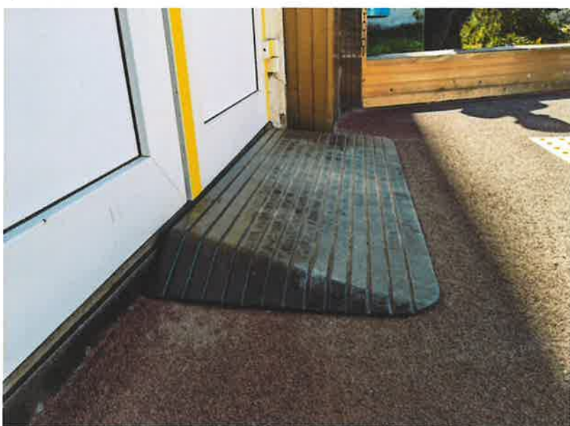
Фото 2.5 Пороговый пандус перед входной дверью
