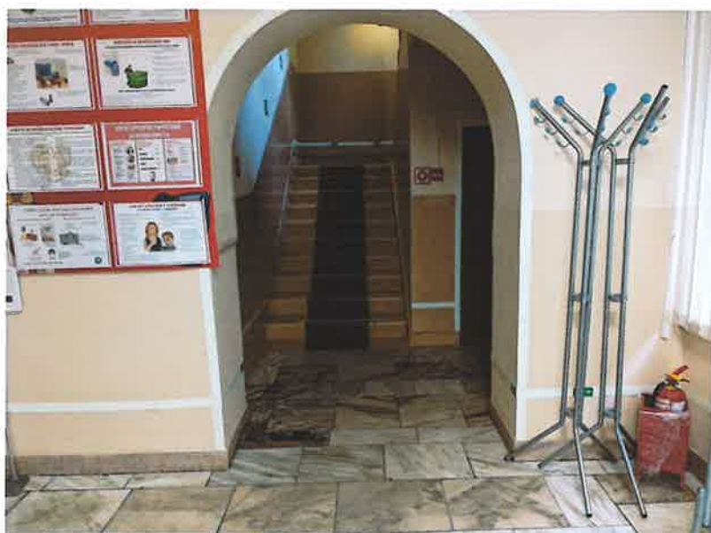
Фото 3.4 Холл 1-го этажа
